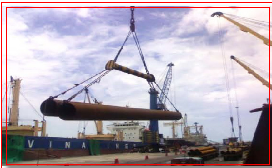
loading لوله های پروژه سیری-عسلویه در بندر mundra هندوستان
